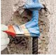
Trattamento di protezione anticorrosiva dei ferri di armatura che, per varie cause, si presentano scoperti, e per i quali il processo di corrosione, subisce una notevole accelerazione.
