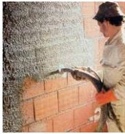
Realizzazione di intonaci esterni su superfici verticali e/o orizzontali mediante macchina intonatrice. L'applicazione dell'intonaco esterno richiede le seguenti accortezze ai fini di buoni risultati:
