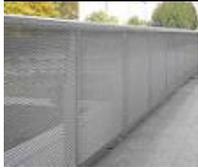
Trattasi della posa in opera di parapetti per balconi di altezza minima pari ad almeno 1,00 mt, a protezione del rischio di caduta dall'alto di persone ed oggetti. I parapetti possono essere realizzati in diversi materiali, quali profilati in ferro zincato e verniciato, in alluminio e vetro, in legno oppure in muratura o calcestruzzo armato.
