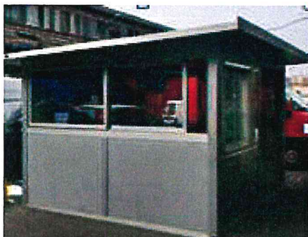
Manufatto esistente in Prima Strada
