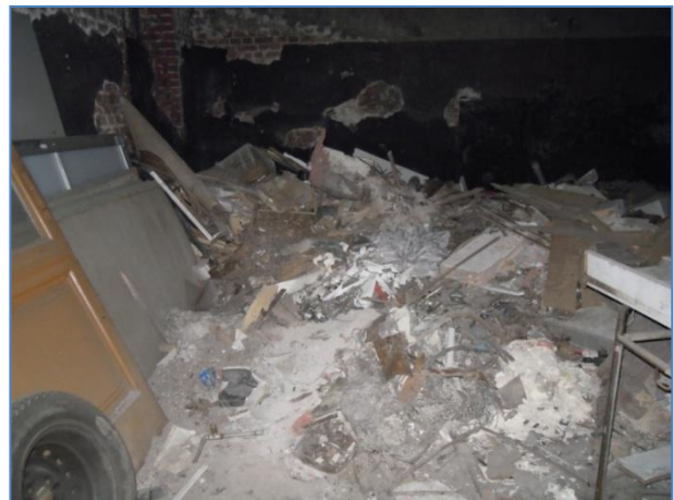
Edificio 04 – Rifiuti e macerie
