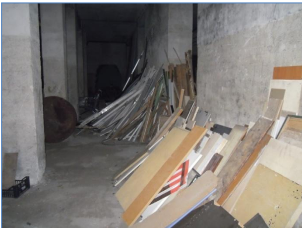
Edificio 04 - Scarti di materiale
