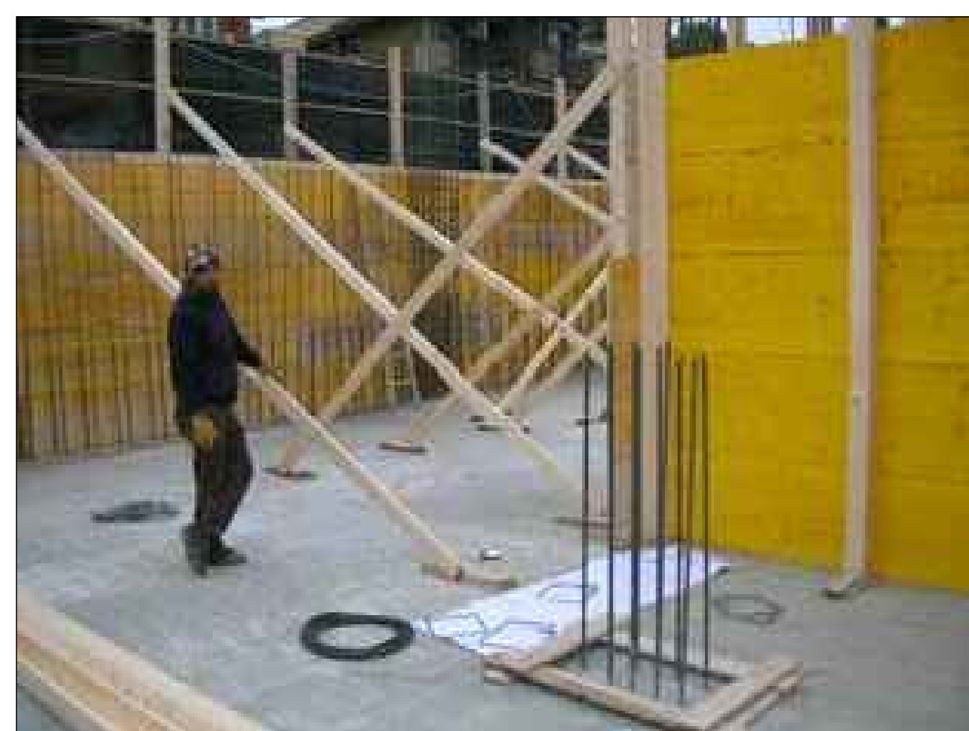
RECINZIONE TIPOLOGIA "B" Realizzazione murature in C.A.: possibile utilizzo di casseri di armatura prefabbricati tipo Peri o casseri tradizionali in legno.
