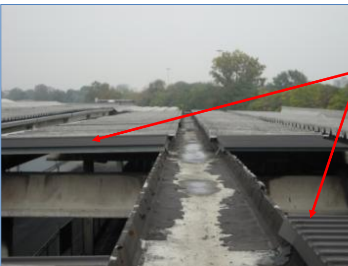
Tettoia 34/5: dettaglio copertura in lamiera grecata a protezione delle attività confinanti con l'area incendiata sprovvista di tetto
