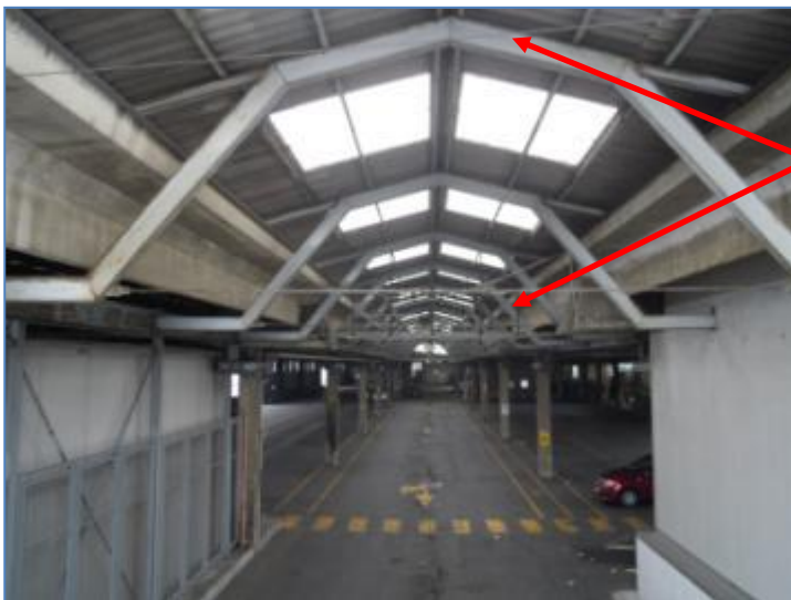
Raccordo fra le tettoie 34/3 - 34/4: dettaglio struttura in carpenteria della copertura
