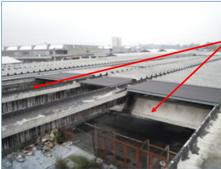
Tettoia 34/5: dettaglio zona danneggiata da incendio
