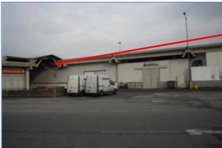
Raccordo tettoia 34/3 - 34/4 con struttura in carpenteria e lastre rette, ondulate, in amianto
