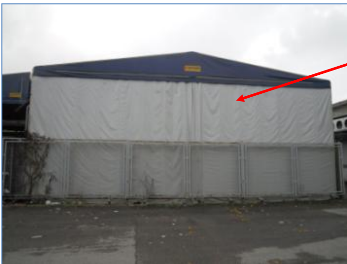
Ampliamento tettoia 34/4 lato Nord con struttura in carpenteria e tendone
