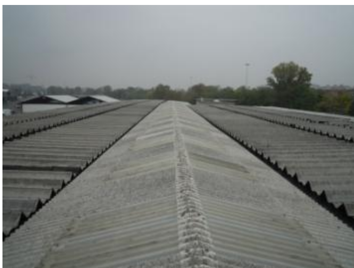
Lastre ondulate tipo eternit – copertura di raccordo fra Tettoie 34/3 e 34/4
