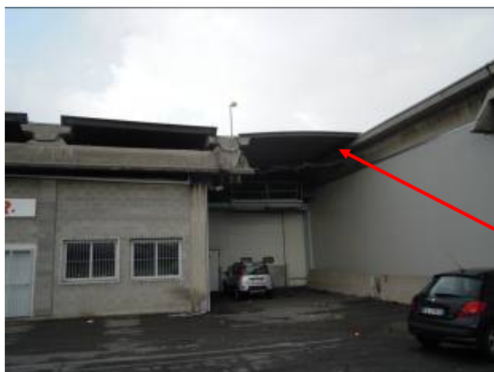
Copertura in copponi autoportanti in amianto fra le Tettoie 34/1 e 34/2
