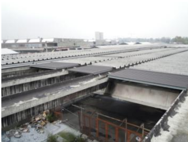
Dettaglio porzione della Tettoia 34/5 danneggiata dall'incendio
