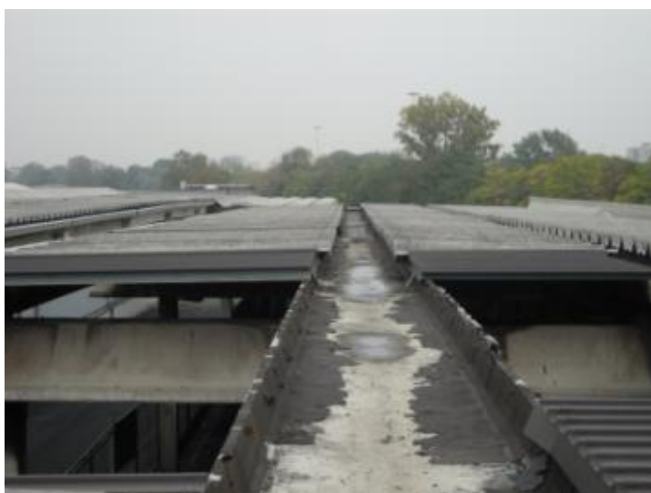
Dettaglio copertura in lamiera grecata su struttura metallica a protezione delle attività confinanti all'area incendiata sprovvista di tetto
