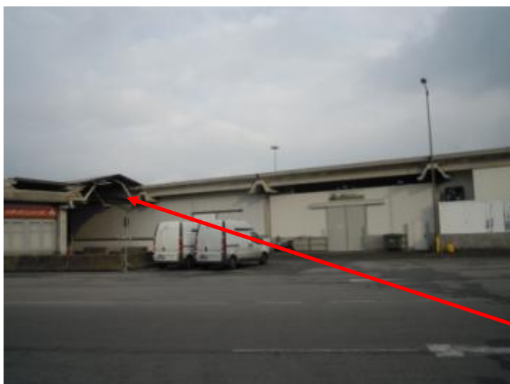
Raccordo tettoia 34/3 e tettoia 34/4 con struttura in carpenteria e lastre rette ondulate in amianto
