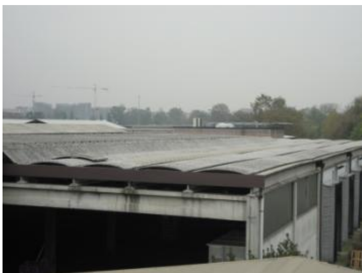
Copertura in pannelli ondulati curvi ampliamento struttura prefabbricata lato Est della Tettoia 34/4
