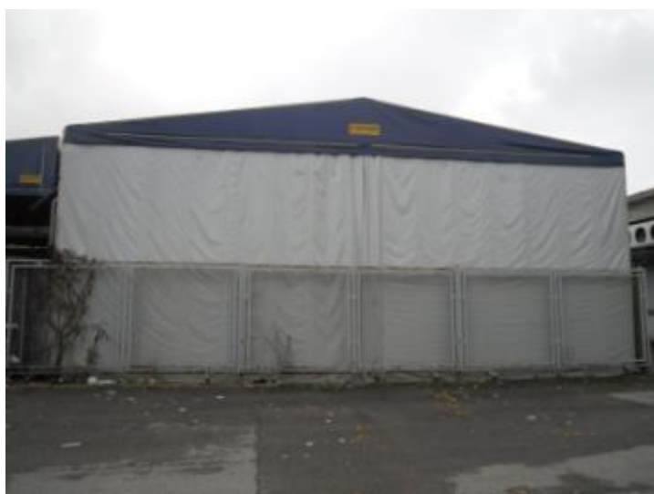
Ampliamento con struttura in carpenteria metallica e tendone tettoia 34/4 lato Nord
