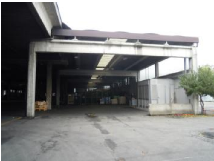
Ampliamento con struttura prefabbricata tettoia 34/4 lato Est con pannelli ondulati curvi in amianto
