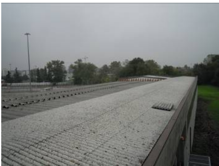
Copertura in lastre ondulate in amianto - ampliamento con struttura prefabbricata lato EST
