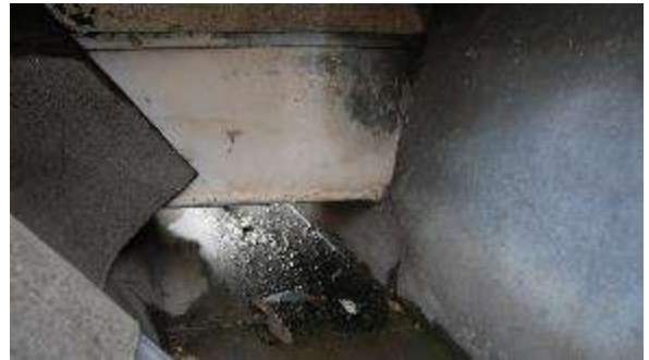
Dettaglio asola collegamento due gronde attigue
