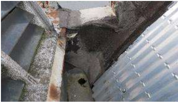
Dettaglio innesto pluviale
