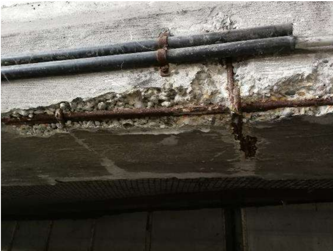
Tipico esempio di degrado superficiale del cls oggetto dell'intervento
