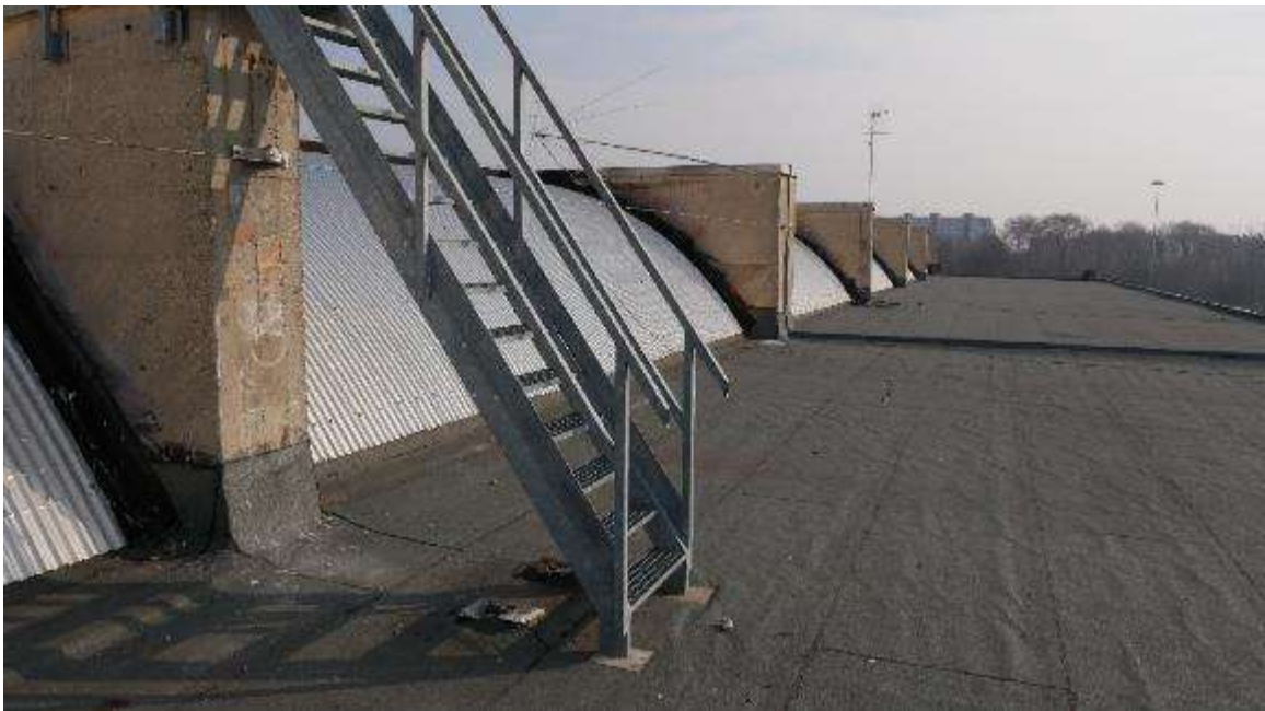
Dettaglio scala di accesso agli estradossi degli shed
