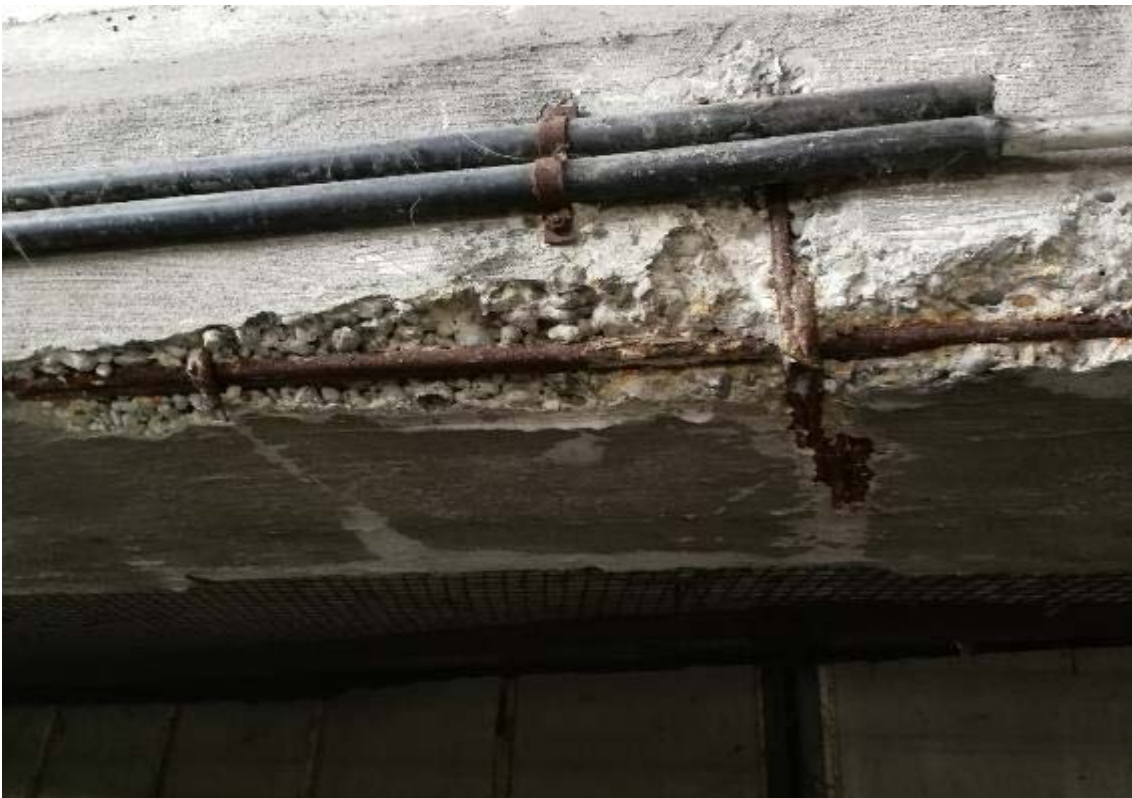
Tipico esempio di degrado superficiale del cls oggetto dell'intervento
