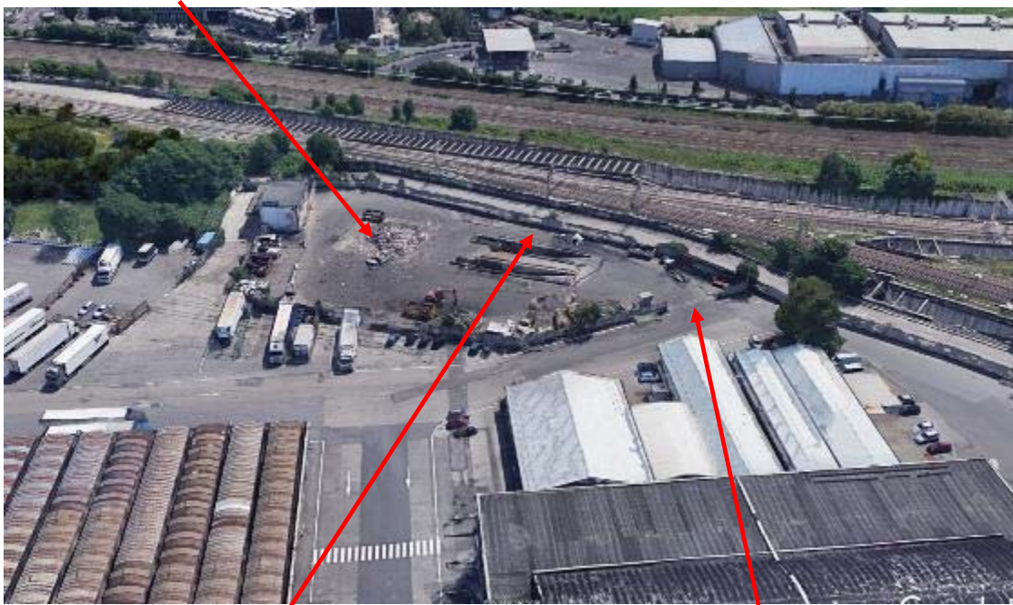
Posizione serbatoio raccolta percolato
