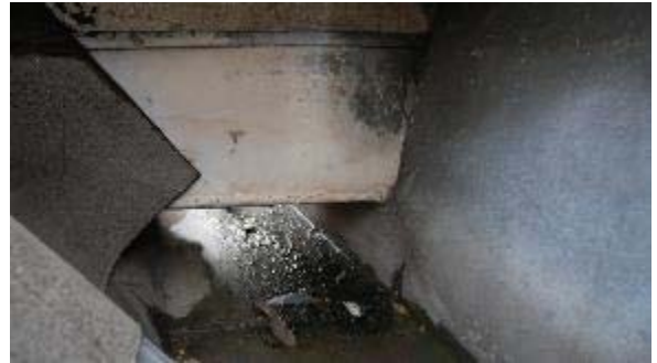
Dettaglio asola collegamento due gronde attigue
