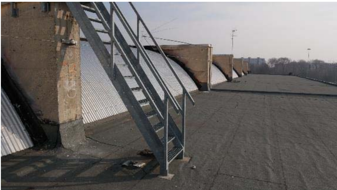
Dettaglio scala di accesso agli estradossi degli shed
