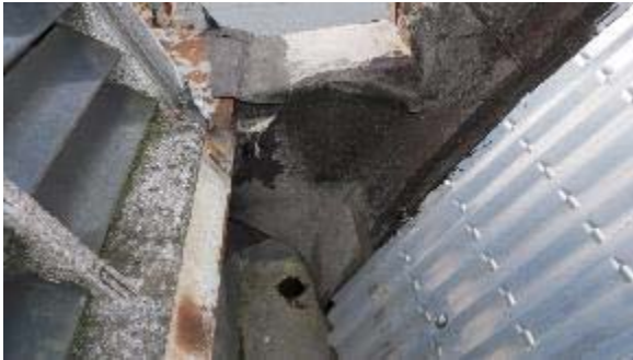
Dettaglio innesto pluviale
