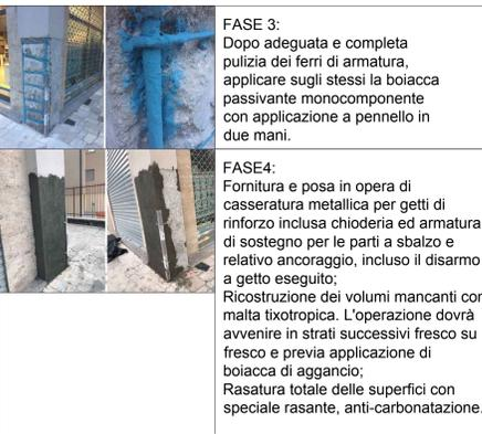
**FASE 3:** Dopo adeguata e completa pulizia dei ferri di armatura, applicare sugli stessi la boiacca passivante monocomponente con applicazione a pennello in due mani.
