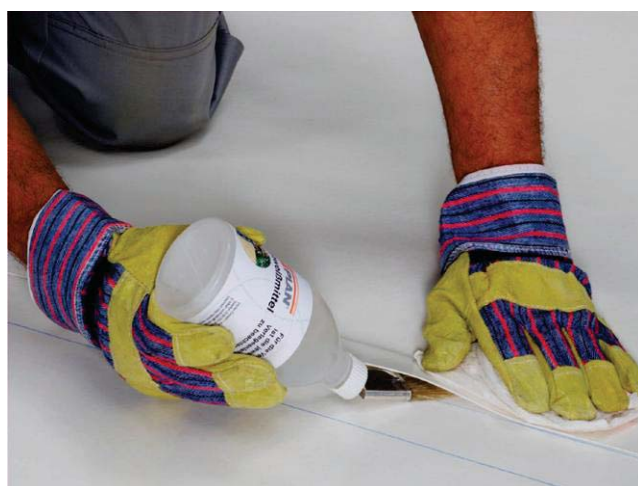
Saldatura sormonti con agente THF Vaefusion
