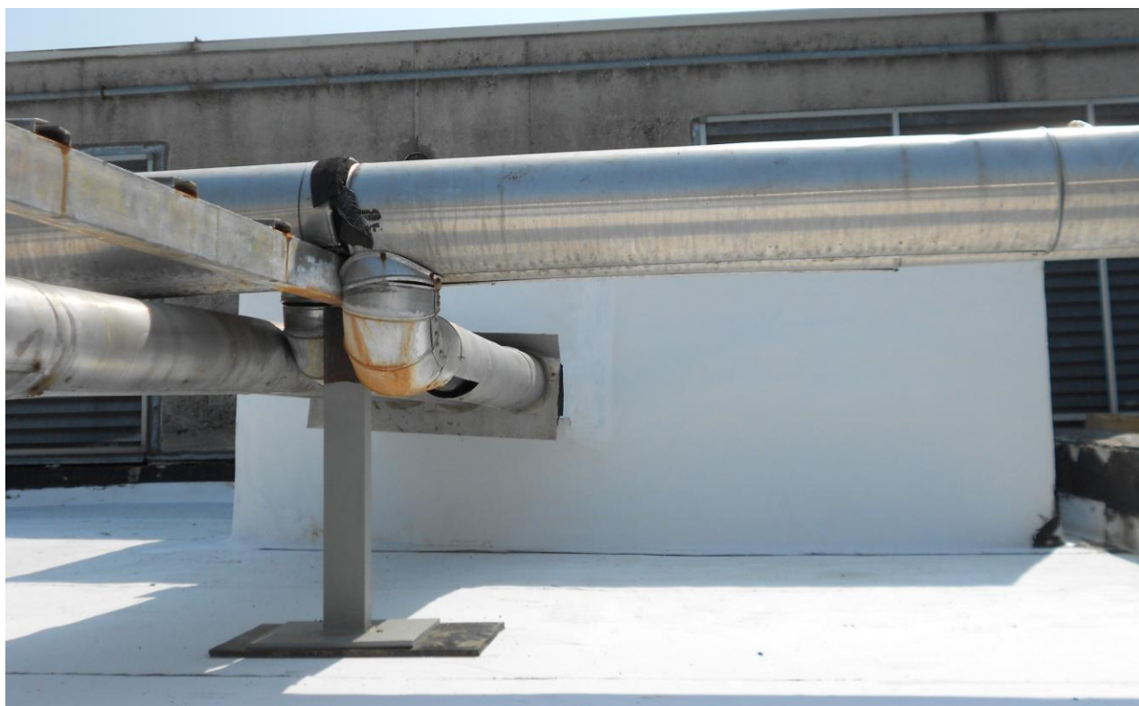
TIPOLOGIA DI SUPPORTO TUBAZIONI DA ADOTTARE (intervento realizzato nel 2015)
