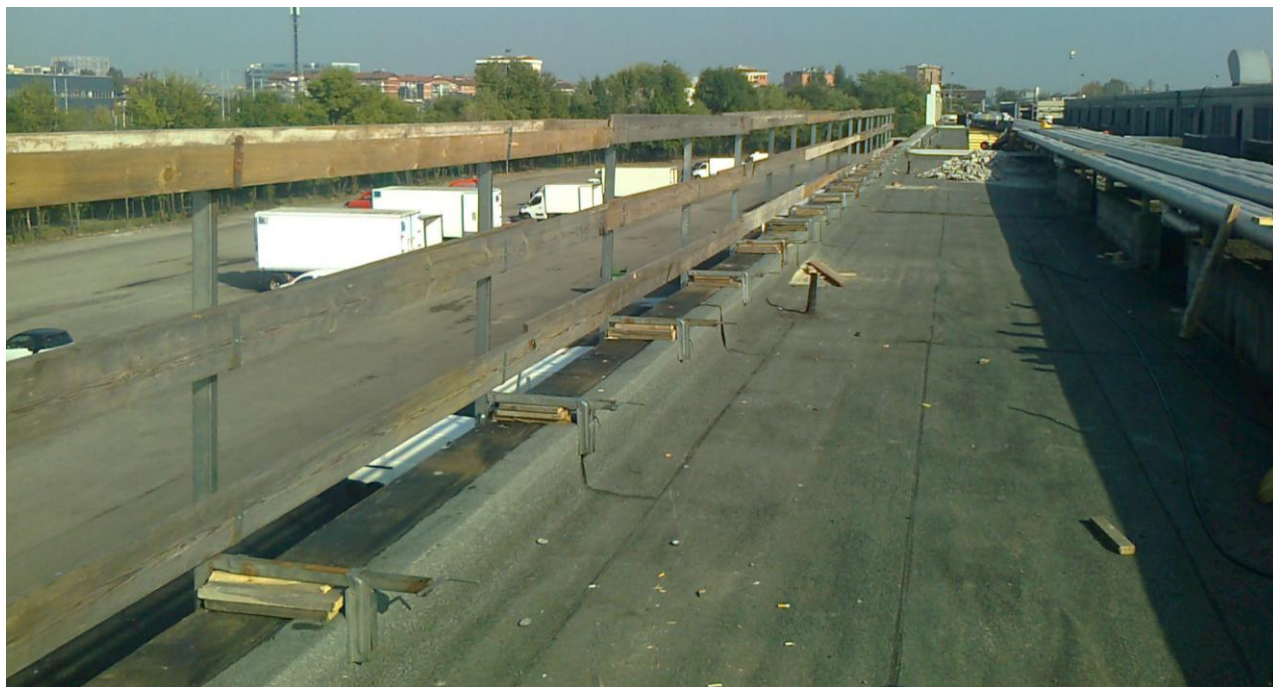
TIPOLOGIA SISTEMA DI PROTEZIONE DA UTILIZZARE DURANTE I LAVORI
