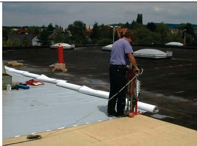
Posa per fissaggio meccanico
