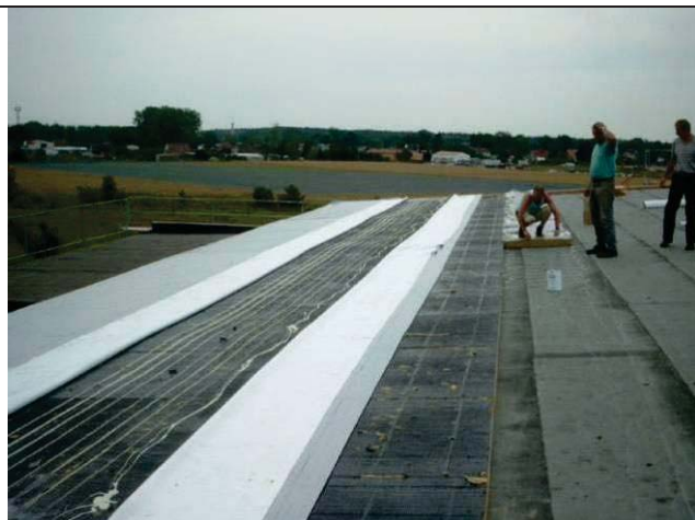
Posa per adesione con colla Vaebond PU
