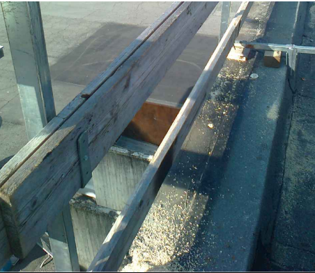
Installazione parapetti di sicurezza
