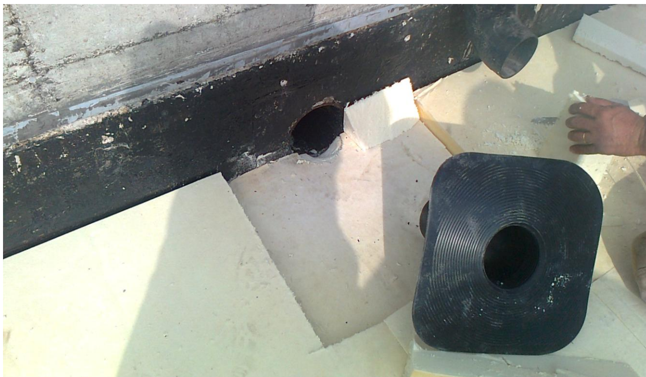
PARTICOLARE TIPOLOGIA SCARICO PLUVIALE DA ADOTTARE
