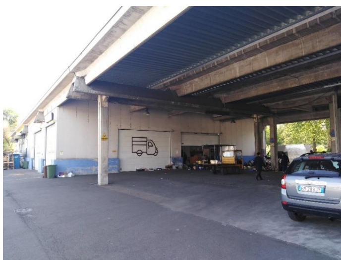
Figura 4: Pilastrini e travi Capannoni prefabbricati esistenti
