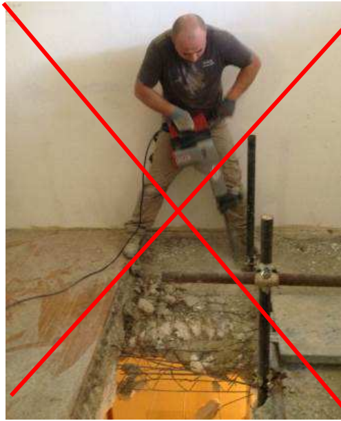
Fig. 1 – Errata postazione di lavoro per attività di demolizione
