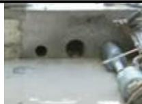
Trattasi della foratura di materiali da edilizia (laterizi, calcestruzzo, pietre naturali, ecc.), mediante l'asportazione, eseguita per abrasione, di una corona circolare di materiale, ottenuta con l'ausilio di una carotatrice, macchina utensile portatile o stazionaria, ossia montata su supporto. La tecnica usata per l'asportazione del materiale, l'abrasione, consente di evitare alle strutture le sollecitazioni tipiche delle maniere tradizionali quali la foratura a percussione.
