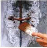
Trattasi del risanamento di calcestruzzo ammalorato da carbonatazione, che si manifesta con la comparsa di fessurazioni capillari in corrispondenza di pilastri. La rimozione del calcestruzzo ammalorato si effettua manualmente oppure con idonei attrezzi ad aria compressa, valutando attentamente le attrezzature da impiegare in modo da non causare danni al calcestruzzo sano.
