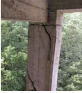
Trattasi del ripristino di strutture in c.a. che presentano fessurazioni capillari, quali lesioni orizzontali in corrispondenza di travi e lesioni verticali in corrispondenza di pilastri. La riparazione delle lesioni deve ripristinare la continuità strutturale di ogni elemento e le tecniche da adottare devono utilizzare prodotti capaci di garantire un'adesione monolitica tra le due parti lesionate e per tutta la profondità della lesione.
